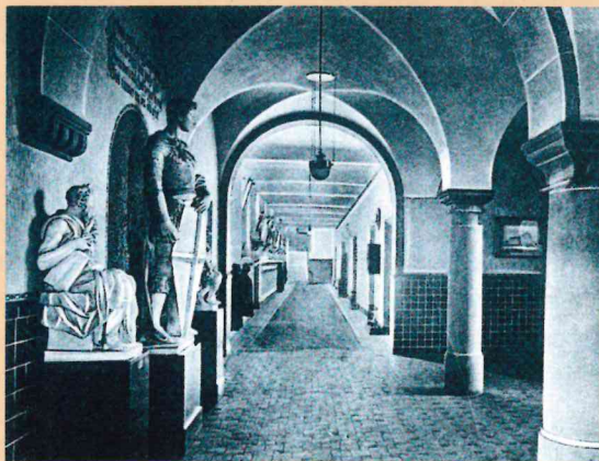
Wandelhalle und Flur im ersten Obergeschoss des Dionysianums.
